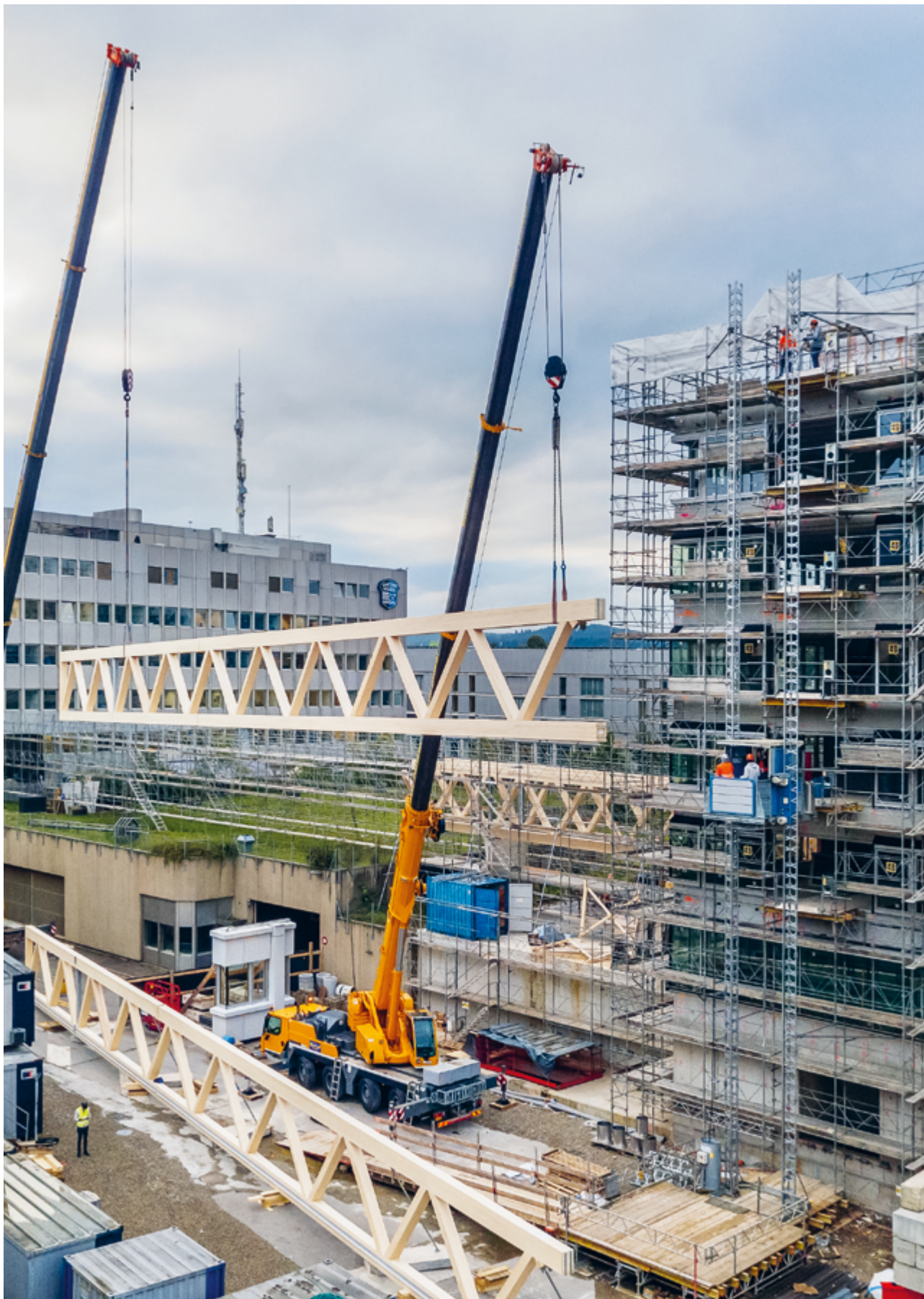
Die neue Passerelle ist gesetzt. Die Verbindungsbrücke vom PKO (Trakt A) zum NPG (Trakt C) misst stolze 65 Meter und bringt rund 35 Tonnen auf die Waage. Sie ist aus 57 m 3 Schweizer Holz gefertigt.
